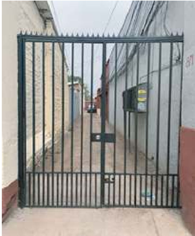
Abate Molina 871 Instalación de cerradura.
