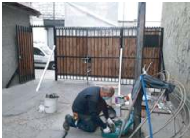
Arauco 1046 instalación portón.
