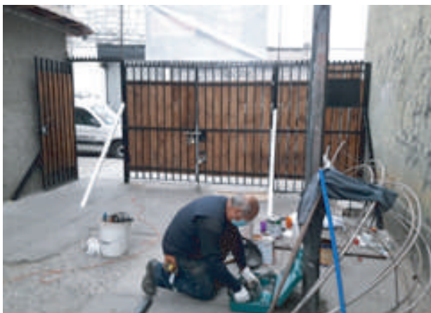
Arauco 1046 instalación portón.
