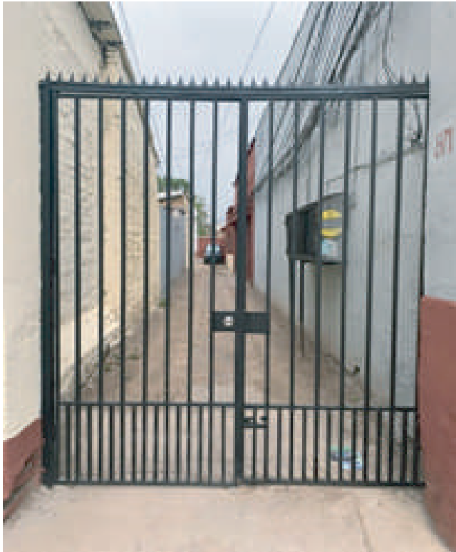
Abate Molina 871 Instalación de cerradura.
