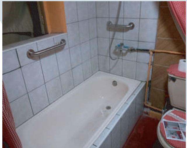
Herrera N° 1262 B - Instalación de barras de seguridad en sala de baño
