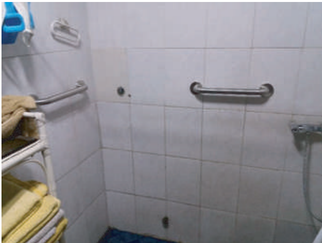
San Francisco N° 375 C/2 - Instalación de 3 barras de seguridad en sector ducha
