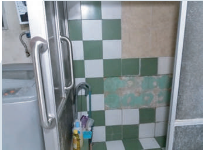
Herrera N° 1251 - Instalación de barras de seguridad en sector ducha
