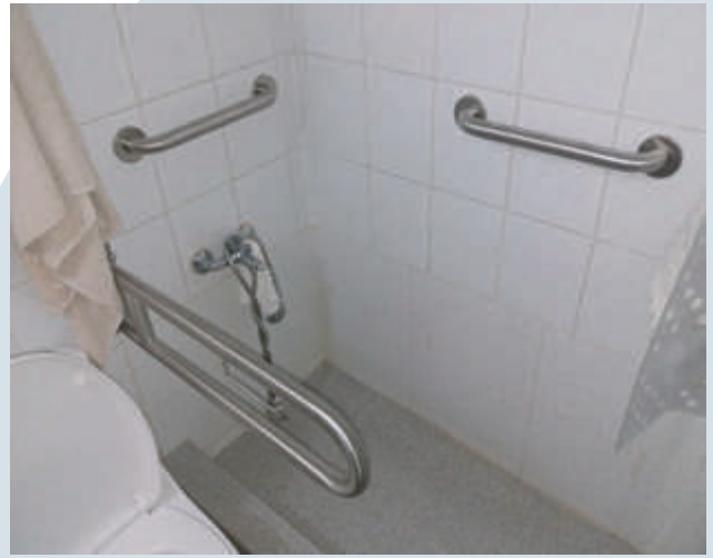
Tarapacá N° 752 D/124 - Instalación de barras de seguridad en sala de baño
