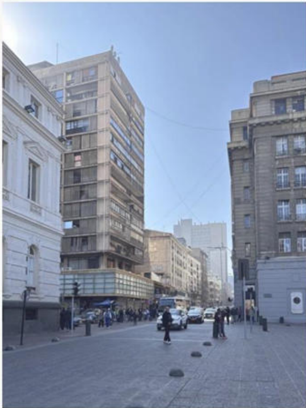
IMAGEN 29_VISTA ACTUAL DE LA FACHADA SUR DEL EDIFICIO.
